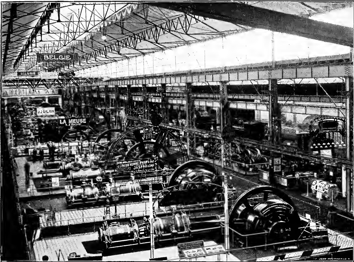
UN ASPECT DU HALL DES MACHINES.
